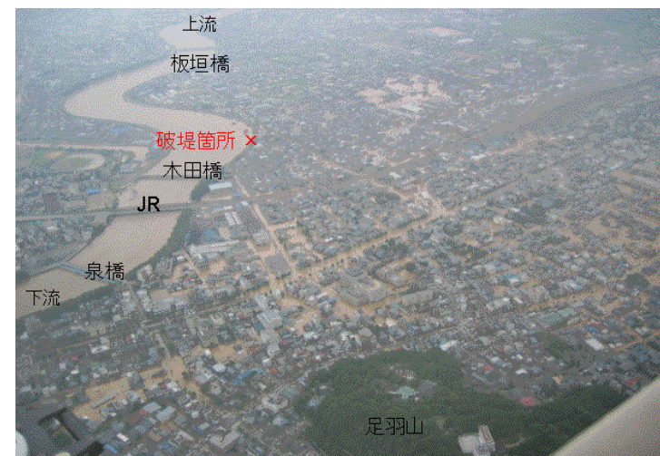
福井豪雨浸水状況(上空から撮影)
